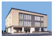
ベルモニー会館 枝松 〈プライベートホール緑 併設〉 松山市枝松3丁目5-15
